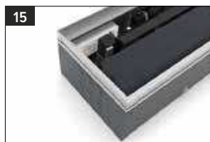
12 Draai de warterl aan met 2,4/4 Nm.
